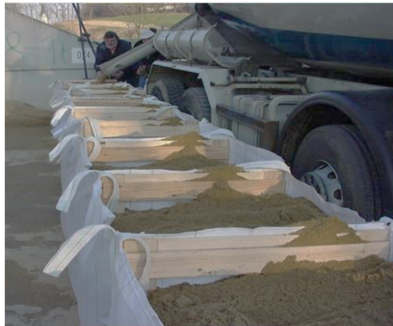
Abb. 63: Abfüllen von versteiften Big Bags mit einem Fahrmischer (INN-PACK).
