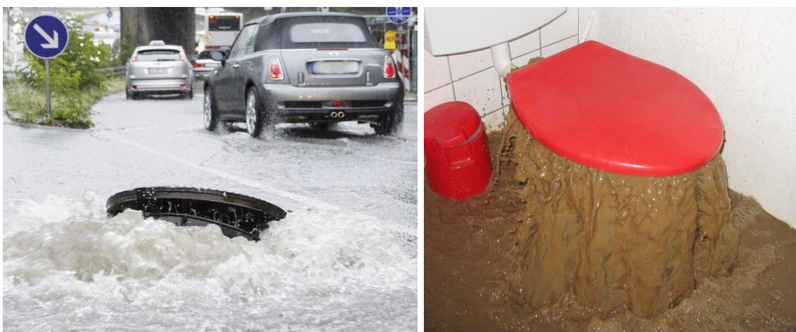
Abb. 14: Rückstau über die Kanalisation (Bruno Gerber, Tiefbauamt Kanton Bern).
