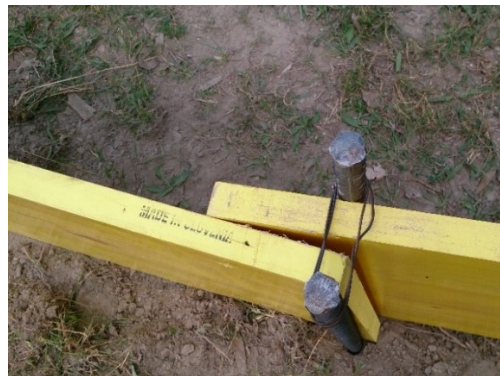
Sicherung der Armierungseisen mit Drill-draht
