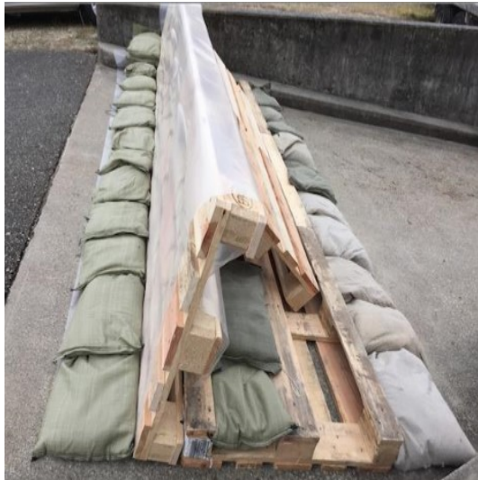
Abb. 59: Palettenwehr mit drei Paletten (Gebäudeversicherung Bern GVB) und Palettenwehr mit vier Paletten (BABS).
