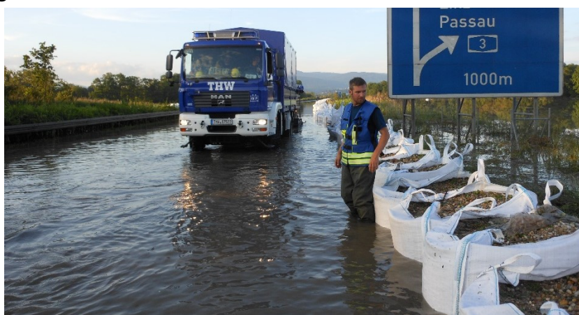
Abb. 62: Improvisiertes Behältersystem mit Industriesäcken (Technisches Hilfswerk THW).
