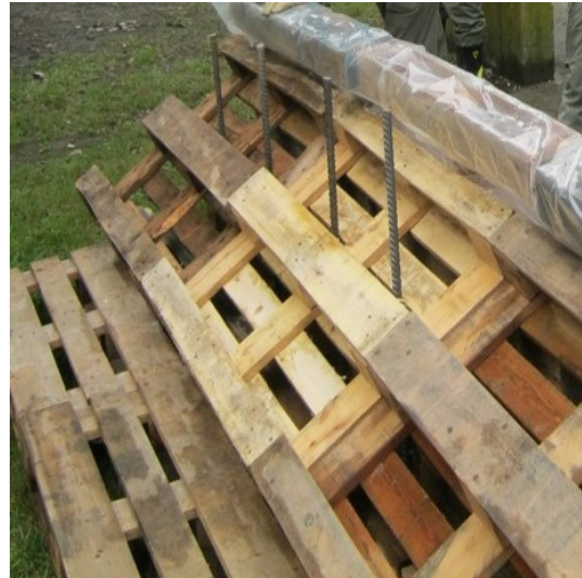
Abb. 59: Palettenwehr mit drei Paletten (Gebäudeversicherung Bern GVB) und Palettenwehr mit vier Paletten (BABS).
