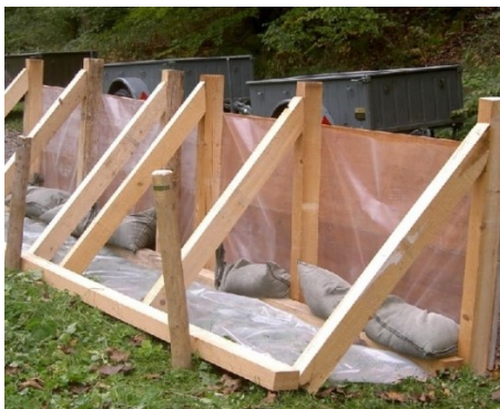
Zusätzliche Abstützung mit Kantholz
