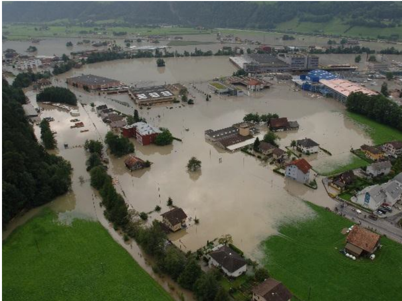
Abb. 3: Statische Überschwemmung in Schattdorf UR (Faktenblatt Hochwasser und Murgänge, BAFU).
