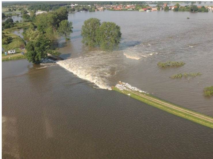
Abb. 68: Deichbruch (Robert Jüpner, Technische Universität Kaiserslautern).
