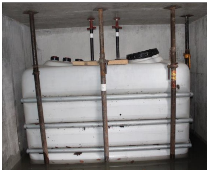
Abb. 82: Sicherung eines Heizöltanks (Gebäudeversicherung Bern GVB).
