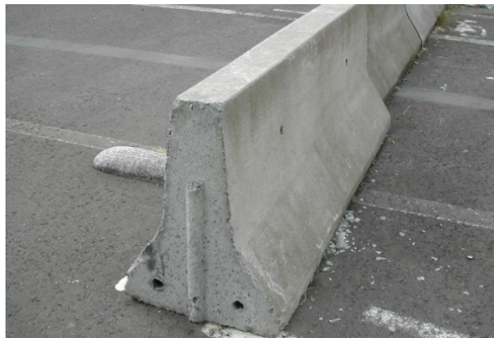
Abb. 64: Elemente mobiler Betonschutzwände (Wikipedia).
