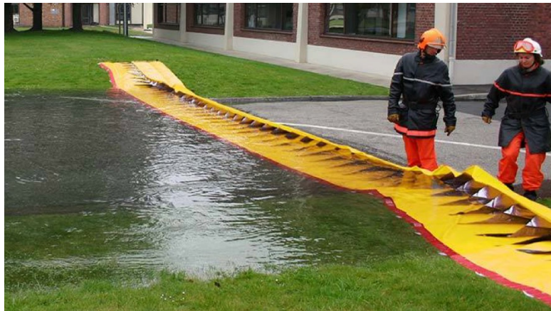
Abb. 61: Klappsystem im Einsatz (MegaSecur Europe).
