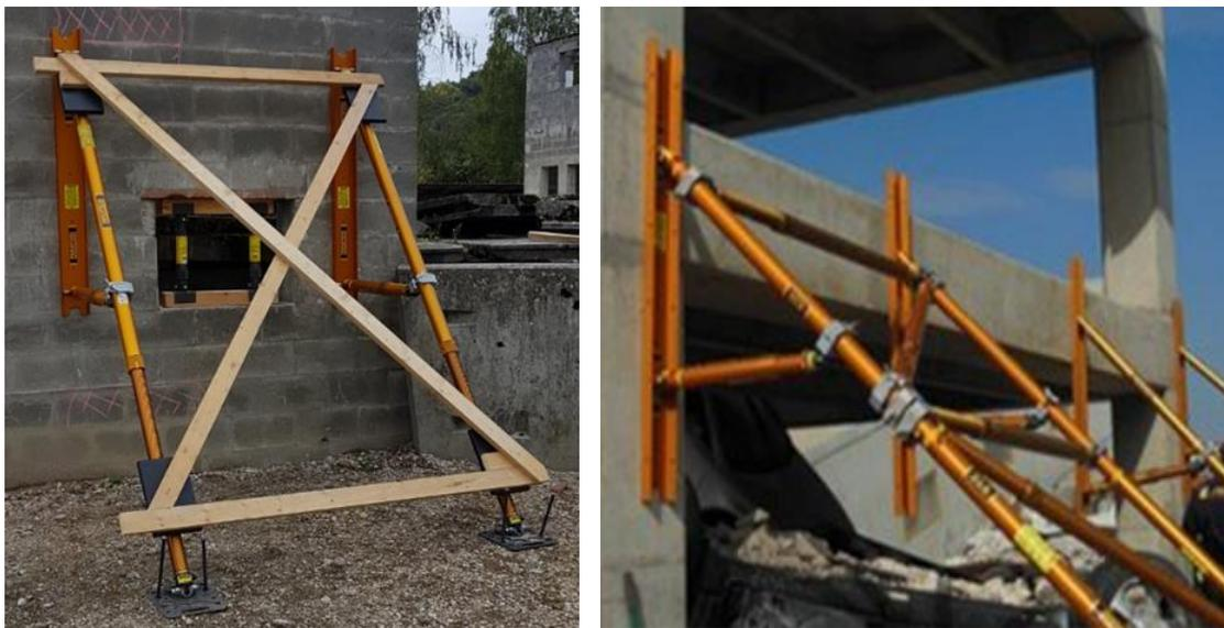
*Abb. 106: Strebstützen mit Systemstützen aus dem Rettungssektor*
