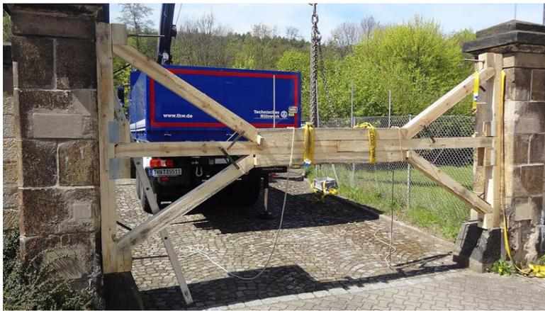
Abb. 79: Beispiel eines Sprengwerks (THW)
