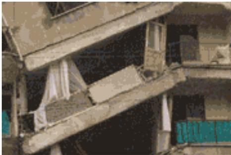
Abb. 4: Ausgefallene/überlastete Auflager
