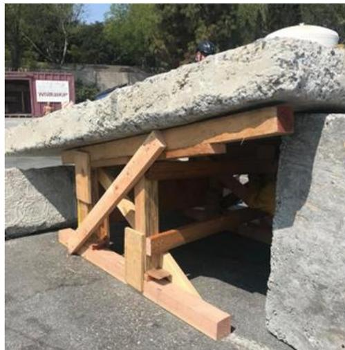
Abb. 95: Schräges Raumfachwerk aus Holz (senkrechte Methode) (FEMA)
