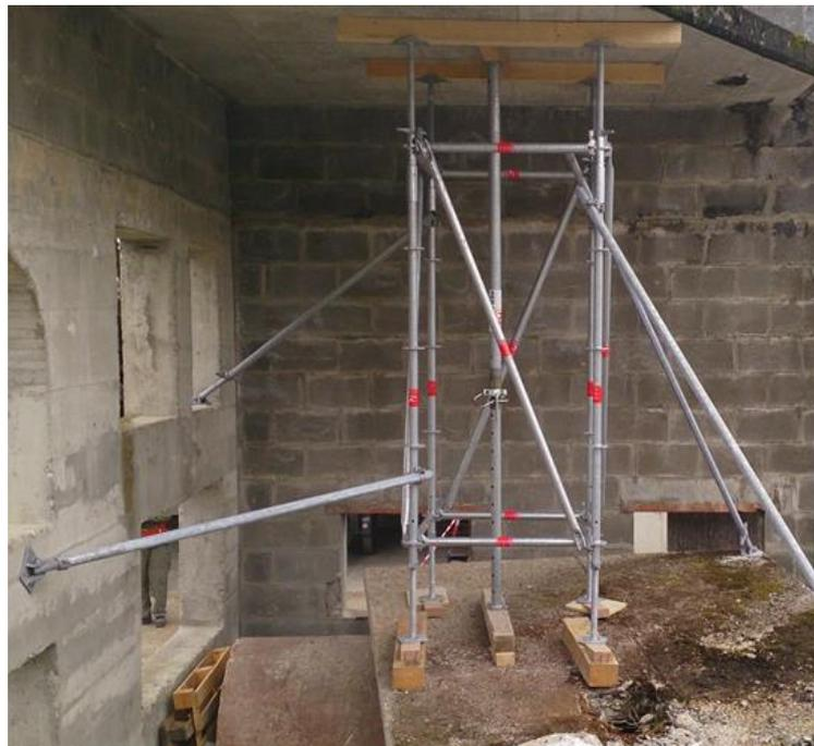
*Abb. 60: Senkrechte Raumfachwerke aus Systemstützen und aus Gerüstbaumaterial*
