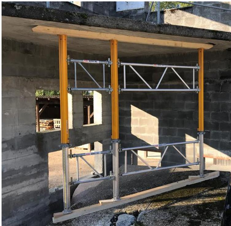
*Abb. 55: Senkrechtcs Flächenfachwerk mit Systemstützen aus dem Bausektor*
