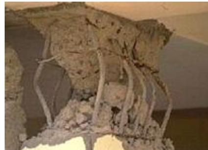
Abb. 5: Freiliegende Armierungseisen
