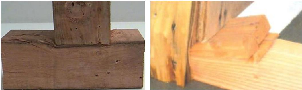
*Abb. 16: In die Schwelle- oder den Unterzug eingedrückte Stützen zeigen eine Überlastung des Abstützsystems an (FEMA)*
