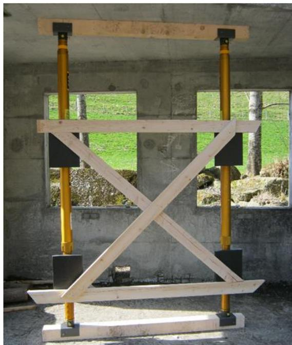
*Abb. 56: Senkrechtcs Flächenfachwerk mit Systemstützen aus dem Rettungssektor*
