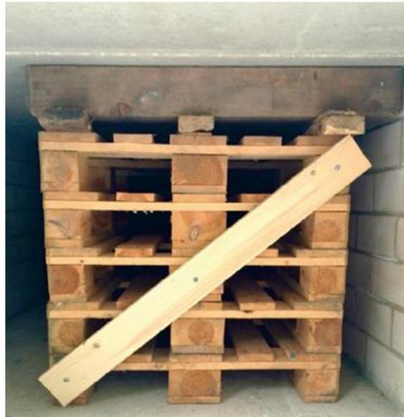
Abb. 71: Beispiel eines korrekt aufgebauten Palettenstapels (Blockhaus, THW)
