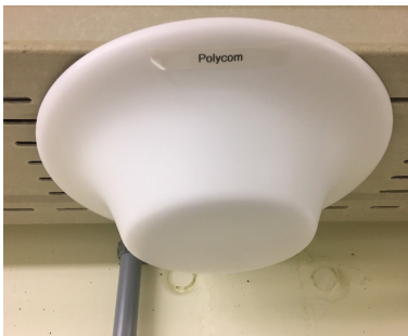
Abb. 36: Beispiel einer Polycom-Rundstrahlantenne (links) und einer Mobilfunk-Rundstrahlantenne (rechts).
